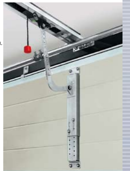
Монтажная консоль на секционных воротах (производство другой фирмы)
